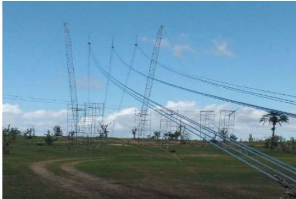
Odoya. 500Kv – Sapeaçu – Morro do Chapéu II. Cable installation
